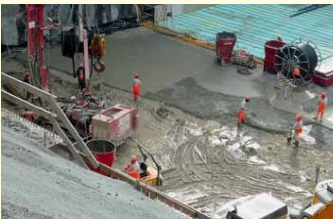
Abb. 4 · Erdwärmesondenfeld HPL mit 101 x 200m GERotherm Erdwärmesonden unter der Bodenplatte. Aushub, Bohrungen, Verrohrung und Bauarbeiten in enger zeitlicher Abfolge
