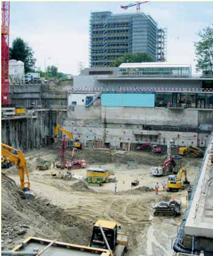
Abb. 2 · Baugrube Erdwärmesondenfeld HPL.
