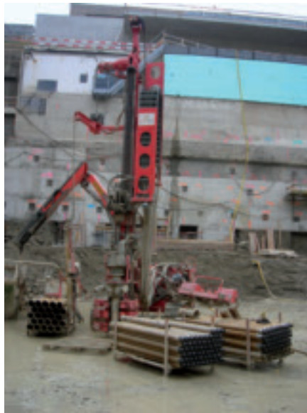
Bohrmaschinen der Fa. Thermatech AG mit abgeteufen GEROtherm® Erdwärmesonden im Vordergrund
