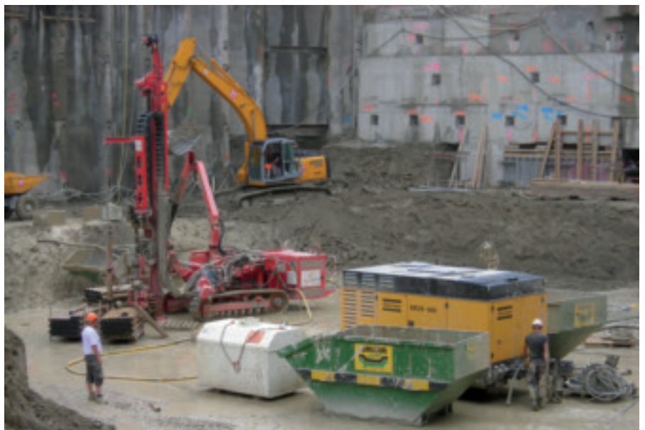
Bohrmaschine in Position für ein neues Bohrloch für Erdwärmesonden
