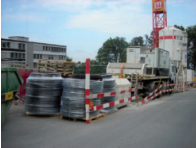
HakaGerodur GEROtherm® Erdwärmesonden im Zwischenlager auf der Baustelle
