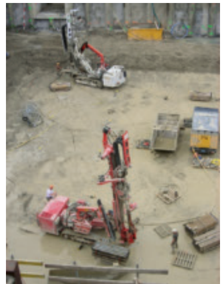
Bohrmaschinen in der Baugrube
