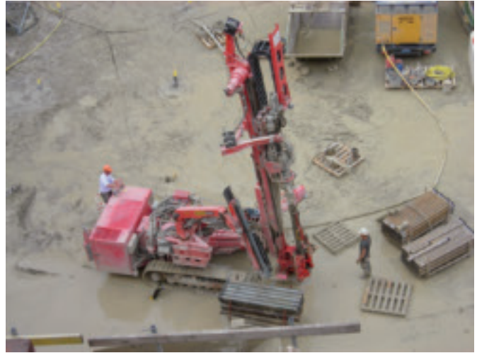
Versetzen der Bohrmaschine auf der Baustelle
