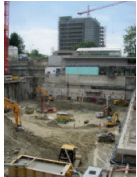
Baustelle ETH HPL Life Science Platform Baugrube 8049 Zürich
