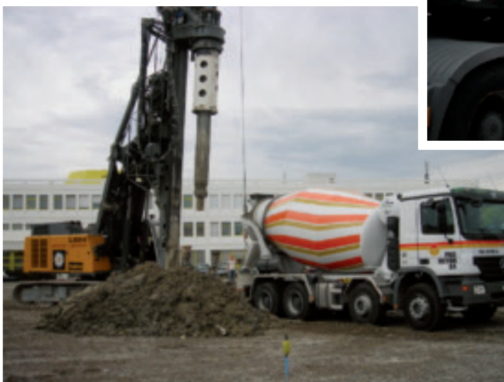
Verfüllen des ersten Energiepfahles
