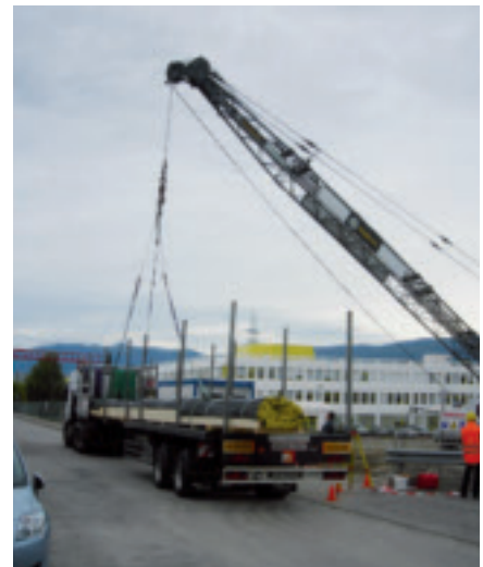
Abladen der GEROthem® Erdwärmepfahlsonden auf der Baustelle
