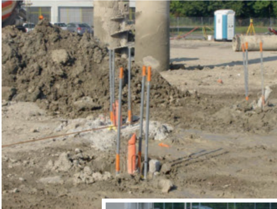
Fertig erstellte Energiepfähle
