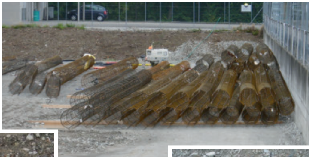
Vorbereitet Pfahlarmierungen auf der Baustelle
