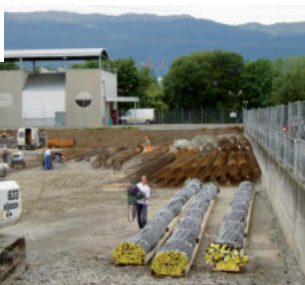
Abgeladene fixierte HakaGerodur GEROtherm® Erdwärmepfahlsonden auf der Baustelle
