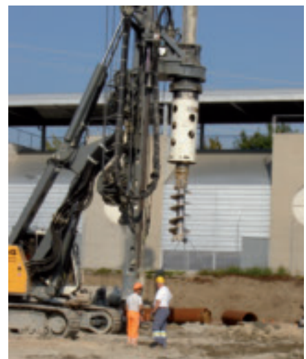
Bohrgerät zur Herstellung der Energiepfähle
