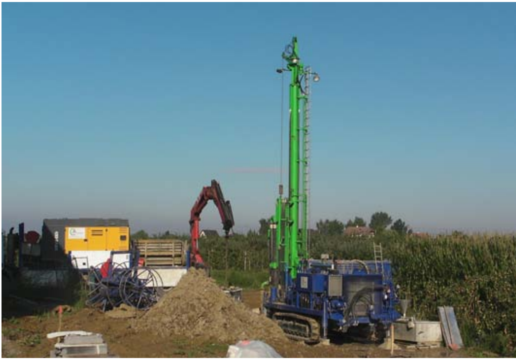
Erste Geothermiebohrung zur Durchführung eines Thermal Response Tests (TRT). Das geologische Profil wurde vor Ort aufgenommen und analysiert. Anschließend wurde Sondenfeld aufgrund der Ergebnisse ausgelegt.
