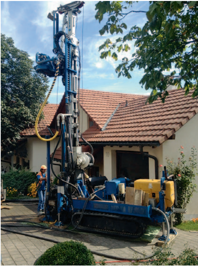
Die Geothermiebohrung wurde direkt im Bereich der Garageneinfahrt geplant und durchgeführt.
