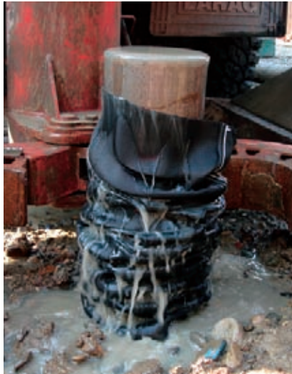
Abb. 5 Vorbereitend wird der Gewebeschlauch über das Standrohr gestülpt.
