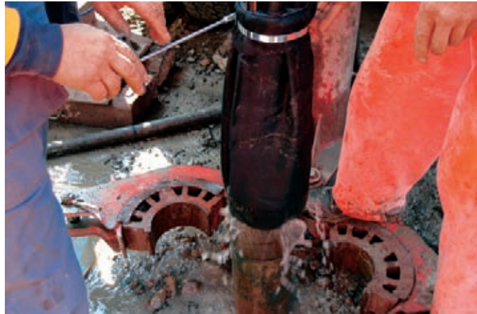
Abb. 4 Montage des oberen Dichtelementes
