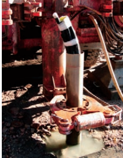
Abb. 6 Nach dem Packereinbau ist der Arteser dicht.
