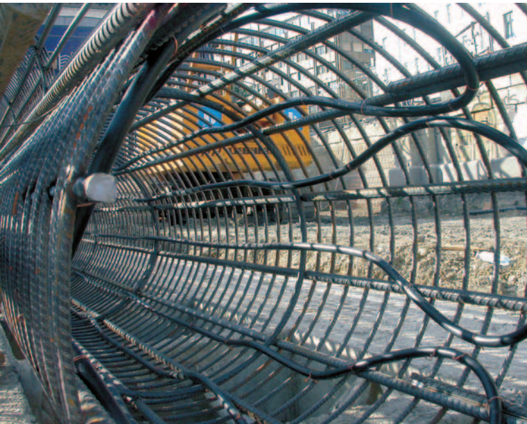
Abb. 3 ■ Blick in einen Bewehrungskorb für einen Energiepfahl \varnothing 1200.
