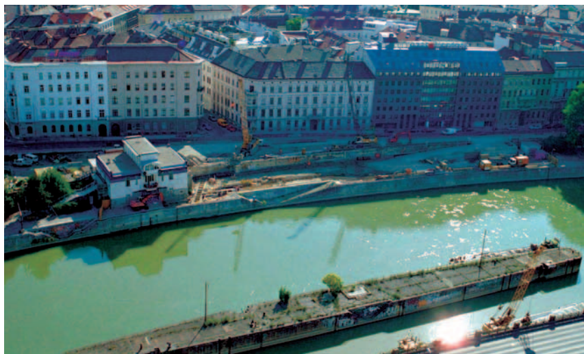
Abb. 1 ■ Luftaufnahme der Baustelle U 2/1 „Schottenring“ mit der Kaiserbadschleuse.
