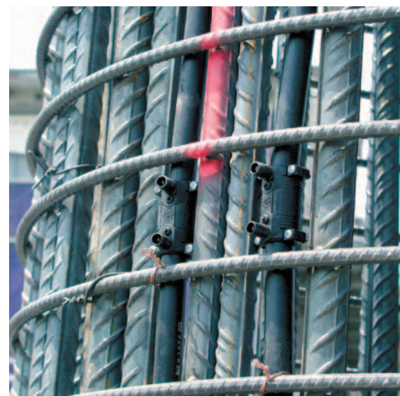
Abb. 5 ■ Verbindung der Energierohre (Vor- und Rücklaufleitung) – Bewehrungskorb für einen Energiepfahl \varnothing 1200 (ohne Deckel).
