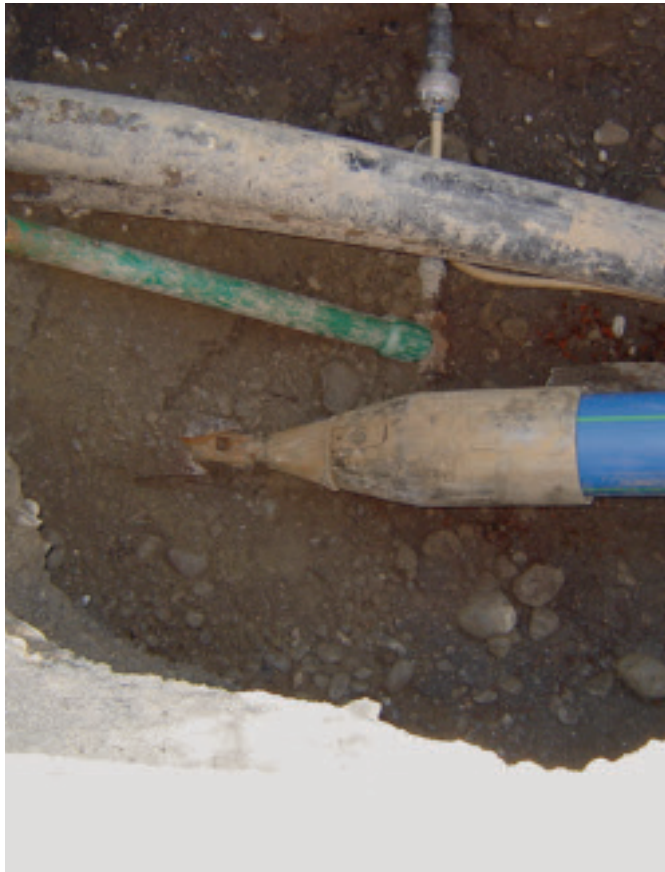
GEROfit-Schutzmantelrohr bei Berstlining
