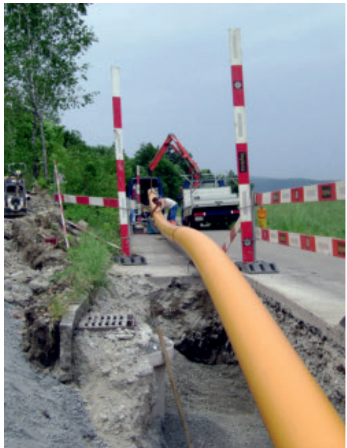
RCprotect, 2-Schicht-Rohr bei sandbettlosem Einbau
