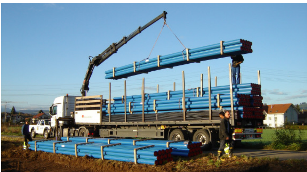
Bild 1: Ablad der in Holzrahmen gelieferten Rohre
