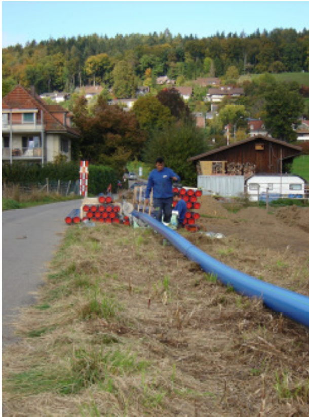
Bild 2: Verschweissung der Stangen
