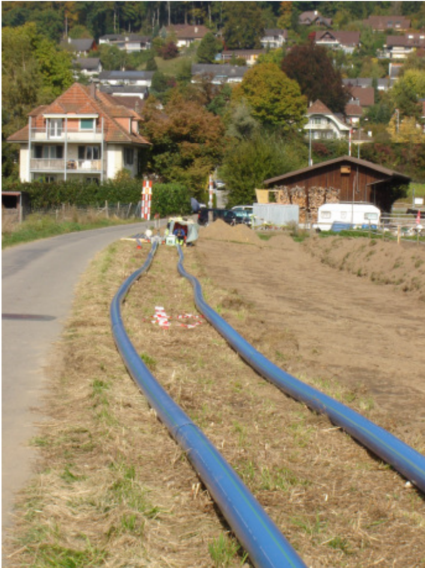
Bild 5: Verschweisste Stangen
