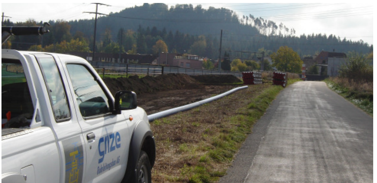
Bild 5: Verschweisste Stangen
