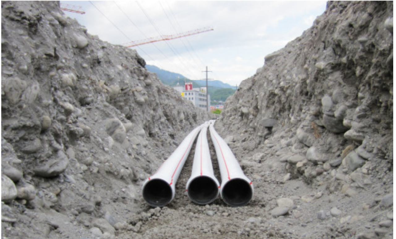
Bild 2: 6er Rohrblock, 1. Lage
