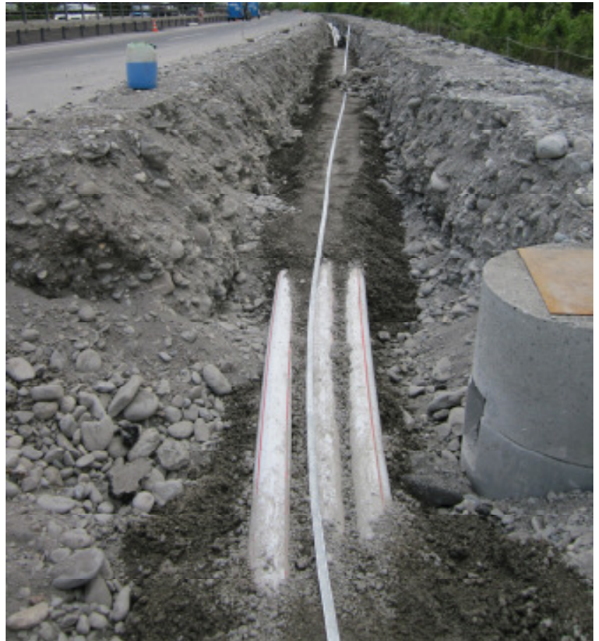
Bild 4: Fertiger Rohrblock mit Erdung
