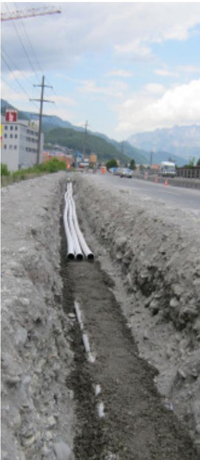
Bild 3: 6er Rohrblock, 2. Lage
