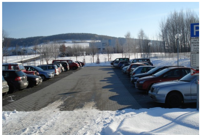
Neuerrichtete Parkfläche bei Schneefall
