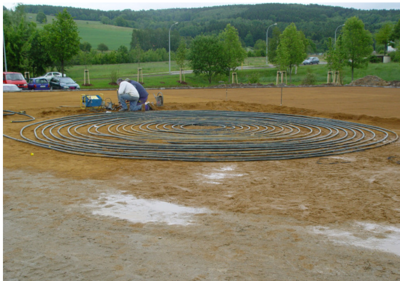
Installation des Wärmetauschers
