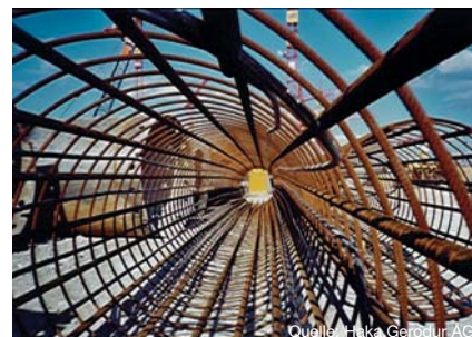
Bild 7 Energiepfahl für Unique Zurich Airport
