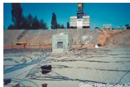
Bild 6 Ausbauarbeiten am Erdwärmespeicher in Neckarsulm-Amorbach
