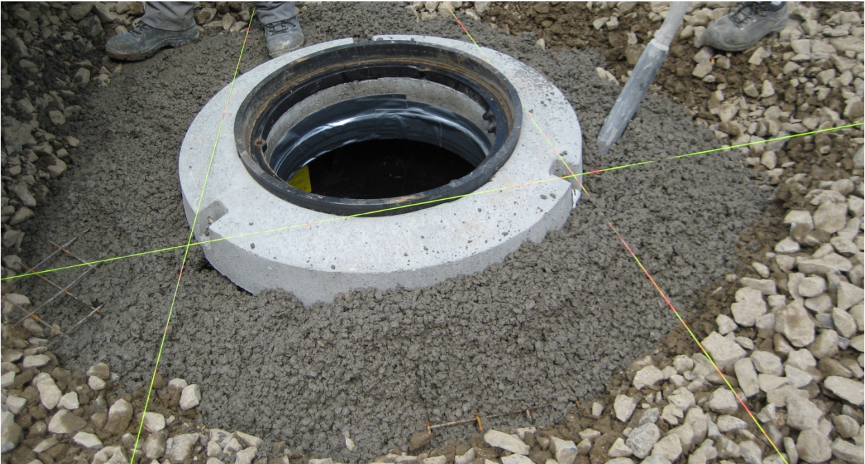
Bild 7: Auffüllen zwischen Armierungseisen und Betonkranz mit Beton, Einsatz von Vibrations-Nadel.
