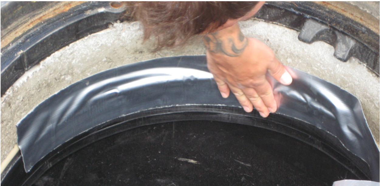
Bild 5: Schutz des Quellbands mit Klebeband bzw. Isolierband.
