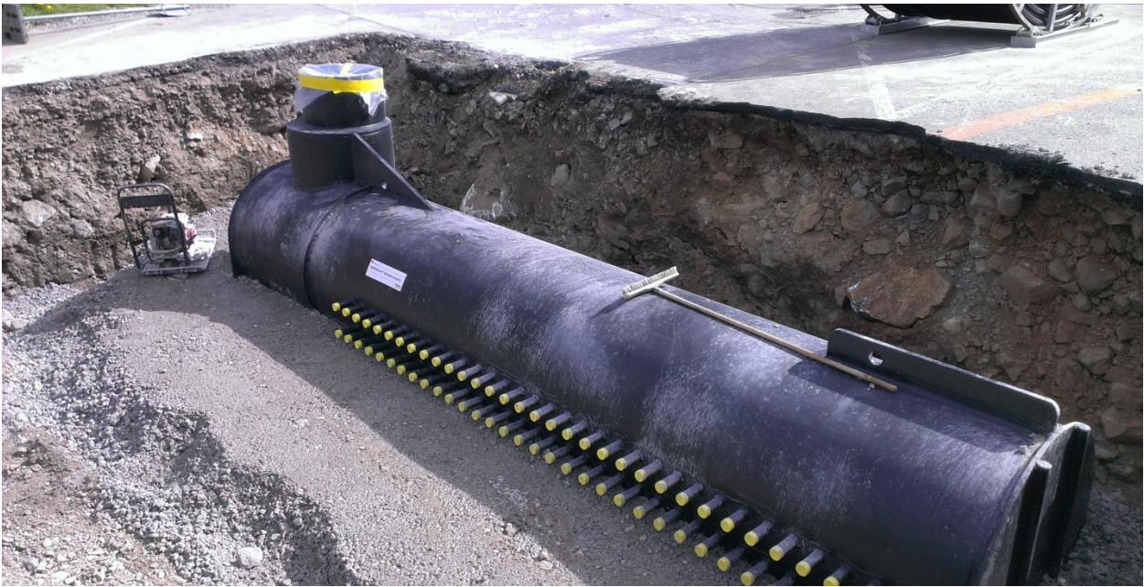
Bild 1: Anlieferung des Verteilerschachtes ohne vormontierten Schachtdeckel D400. Fundament mit Kies 0-16mm oder Magerbeton verdichtet.
