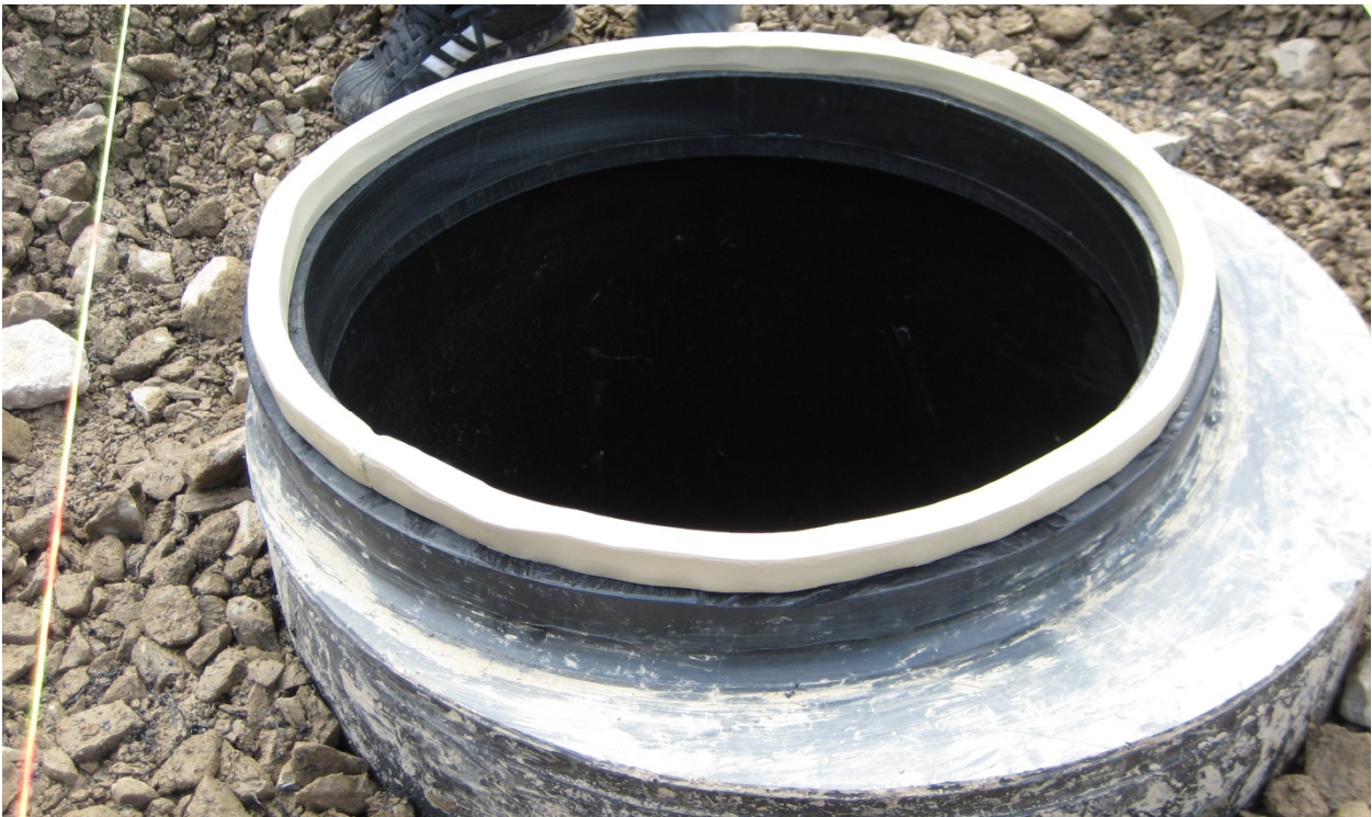
Bild 3: Montage eines Quellbands gegen Tagwassereintritt in den Schacht.
