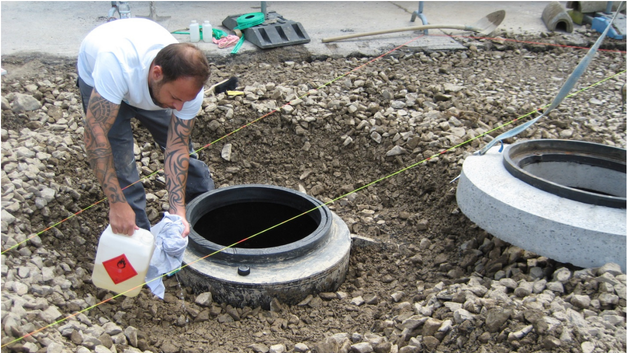
Bild 2: Aufschüttung des Verteilerschachtes mit Schotter und sortiertem, gut verdichtetem Aushubmaterial. Anschliessende Reinigung des PE-Dom.
