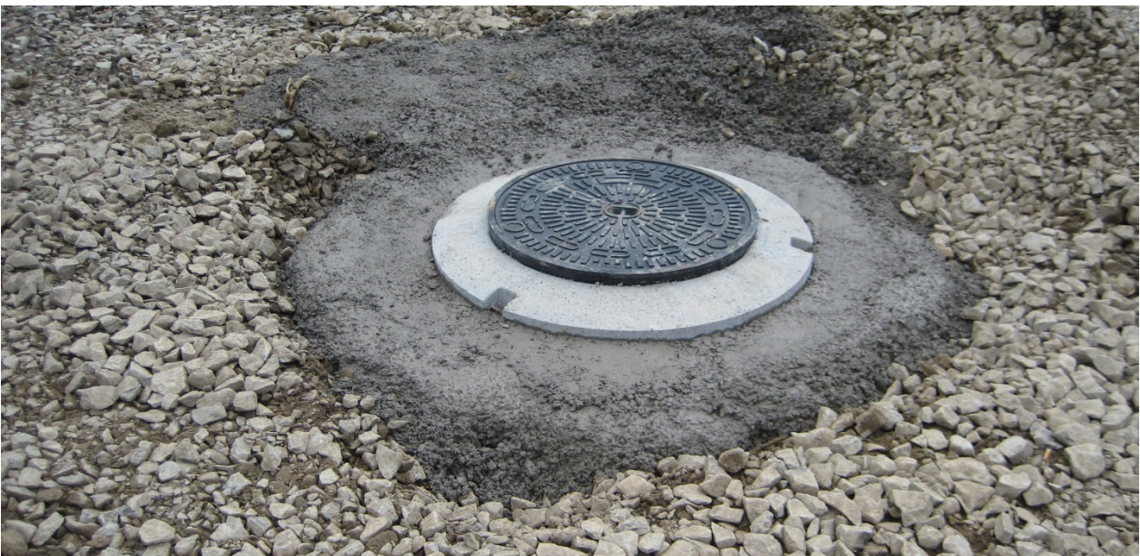
Bild 8: Ansicht nach Abschluss und Verdichtung des Betons. Die Last des Strassenverkehrs wird über den Betonkranz auf den Strassenuntergrund verteilt und nicht auf den PE-Dom.
