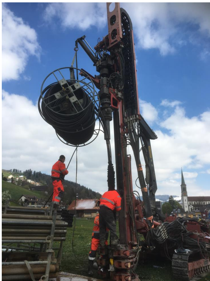
Abbildung 2: Einbau eines Erdwärmesonden-Strumpfs (Quelle: CSD Ingenieure AG)
