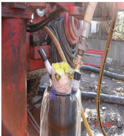
7. Packer mit Injektionsrohr mit Zement füllen und unter Druck halten, bis der Zement abgebunden ist.
