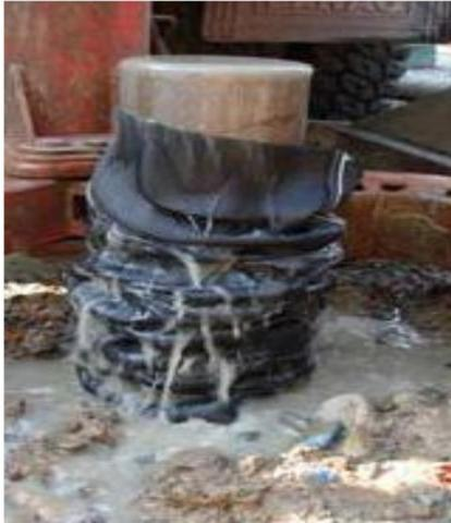
1. Gewebeschlauch über Standrohr stülpen.
