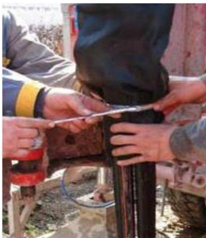
3. Gewebeschlauch fixieren mit 1. Rohr Bride.
