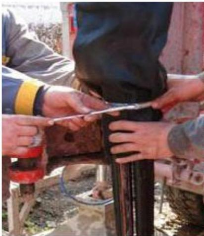
5. Gewebeschlauch fixieren mit 1. Rohr Bride.
