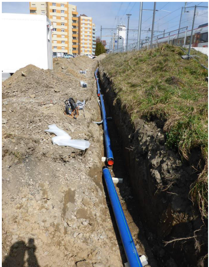
GEROfit® REX bereit im Graben zur Verarbeitung
