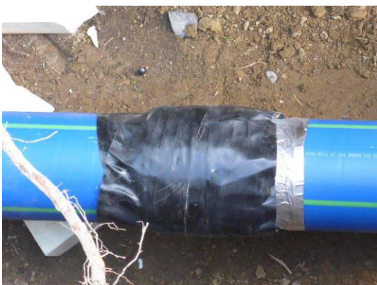
Geschützt mit Dichtungsband
