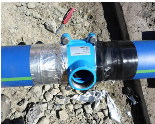
Anschlussfitting Typ HAWLE montiert
