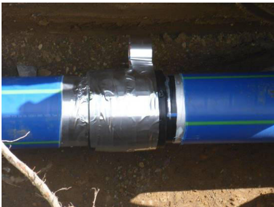
Umwickelte Schweissverbindung mit Alu-Band
