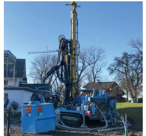
**7** GEROtherm®-REX im Bohrloch, im Hintergrund das Bohrgerät
