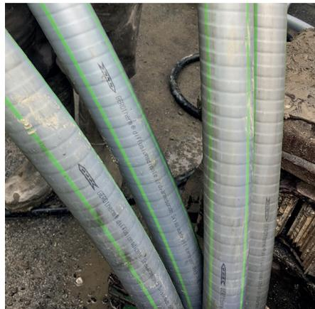
**6** Die bewährte Signierung mit den Flussrichtungspfeile sind sowohl auf dem Kernrohr wie auf dem Schutzmantel aufgedruckt.
