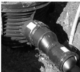
Steckmuffen-Anbindung an Kunststoffschacht
