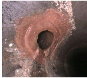
Anschluss instandgesetzt
