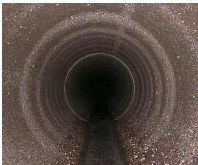
Biegesteifes Rohr leicht ausgewaschen
