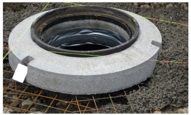
Abbildung 3: Abstützung Betonauflagering
