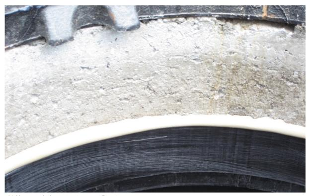
Abbildung 2: Schichtprinzip mit Betonauflagering
