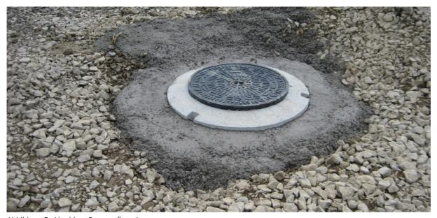
Abbildung 5: Abschluss Betonauflagering
