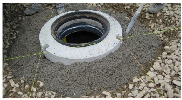
Abbildung 4: Abstützung Betonauflagering
