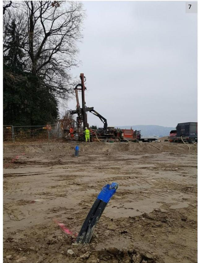
Bild 7: Bereits abgeteufte, hinterfüllte und druckgeprüfte Erdwärmesonden
