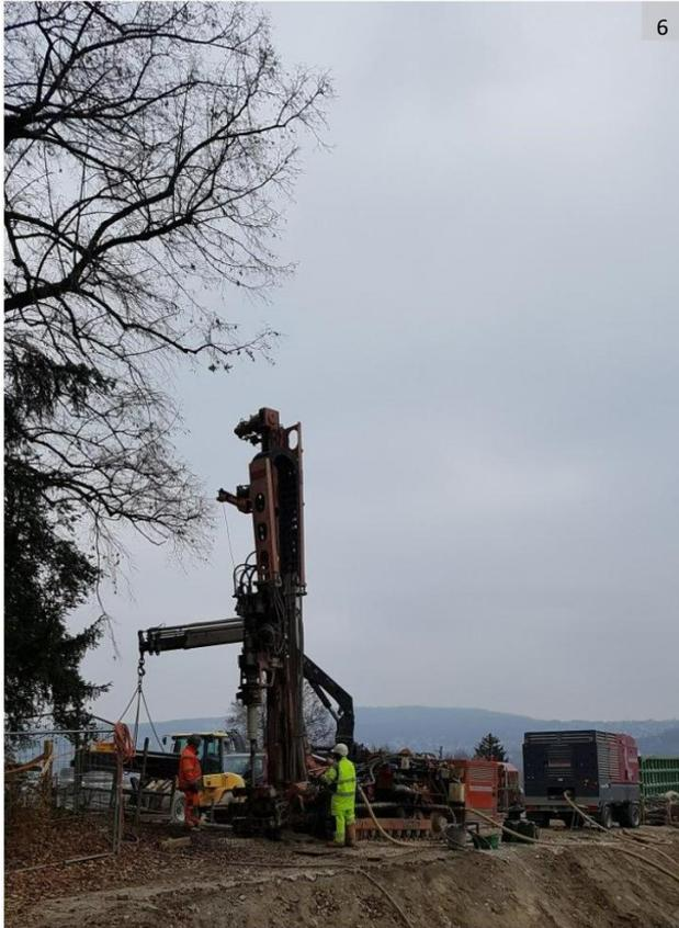
Bild 6: Bohrteam im Einsatz
