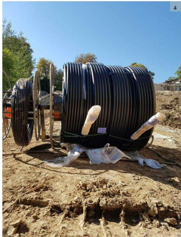
Bild 4: Die GEROthem® FLUX Erdwärmesonde bereit für den Einsatz
