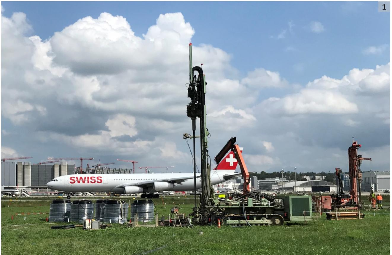
**Bild 1:** Baustellenübersicht, mit zwei Bohrgeräten und den Erdwärmesonden
