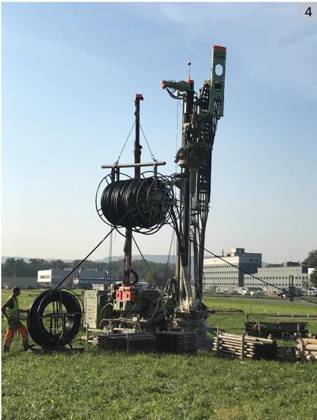
**Bild 4:** Abteufen einer Erdwärmesonde
