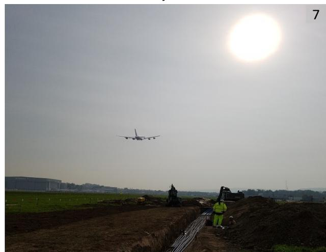
**Bild 7:** Einbau der Anbindungsleitungen GEROfit® Schutzmantelrohr mit PP Schutzmantel de 50mm PN16
