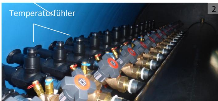
**Bild 2:** Temperaturfühler an jedem Kreislauf
