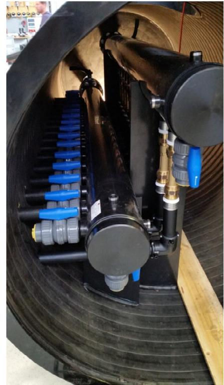
Bild Legende Innenansicht mit Sammler und Verteiler SAVE
