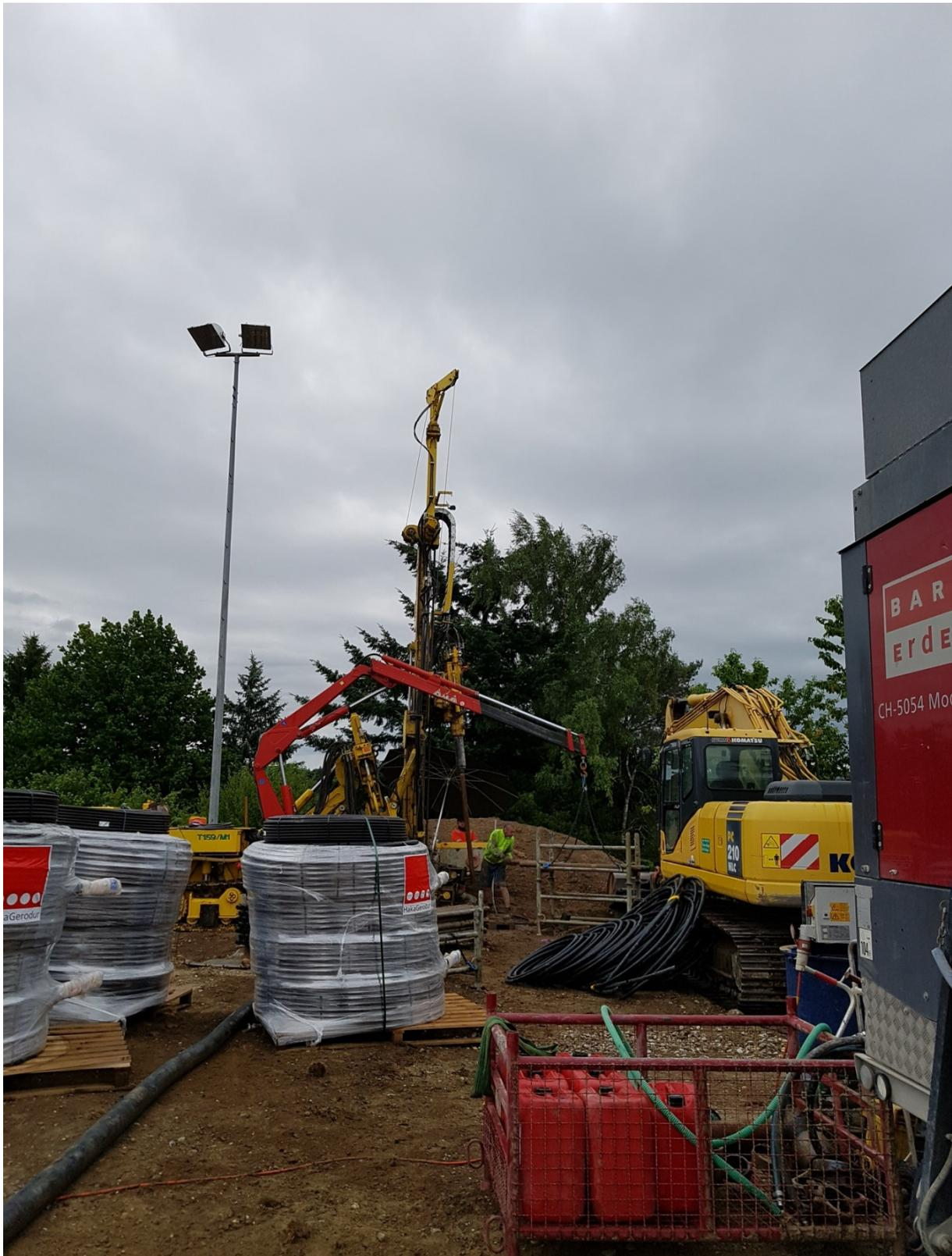
Bild Legende: Bohrergerät mit GEROtherm® FLUX Sonden
