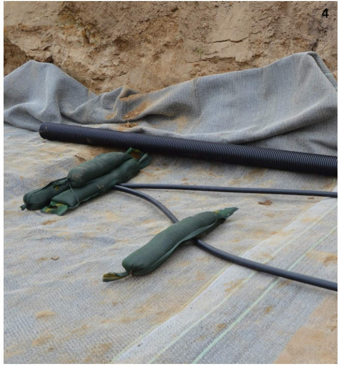
Bild 4: GEROtherm® Sonde als Horizontalkollektor Foto: www.termonet.dk
