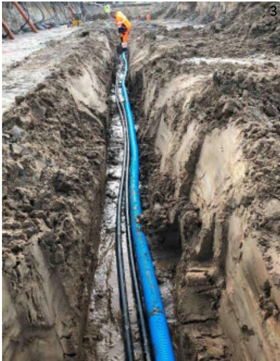
Bild 3: GEROtherm® Sonde neben Abwasserleitung Foto: www.termonet.dk
