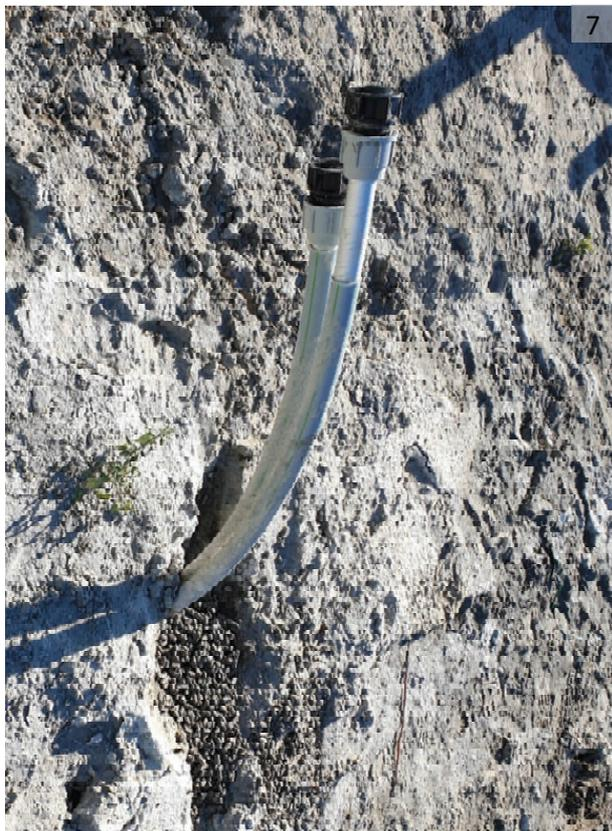
**Bild 7:** Bereits abgeteufte GERotherm® REX Erdwärmesonden
