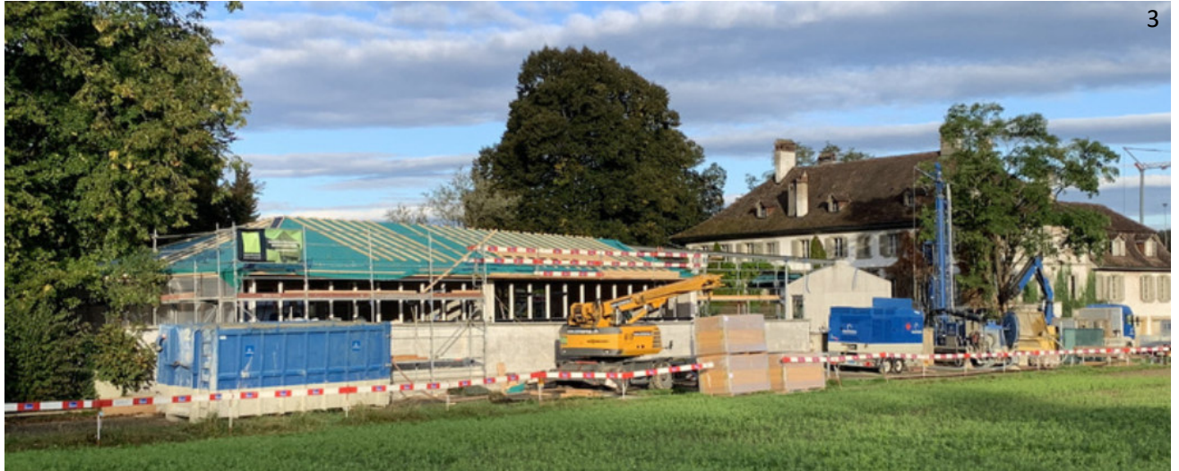
Bild 3: Das Cottage wird aufgerichtet, parallel werden die Erdsonden gebohrt.
