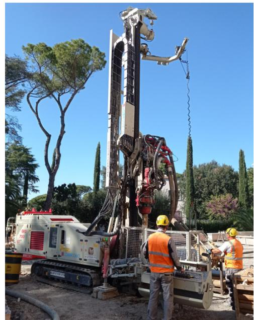
Bild 6: Das Bohrgerät Comacchio GEO 700GT
