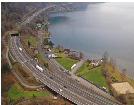
Übersicht von oben Foto: Abwasser Uri
