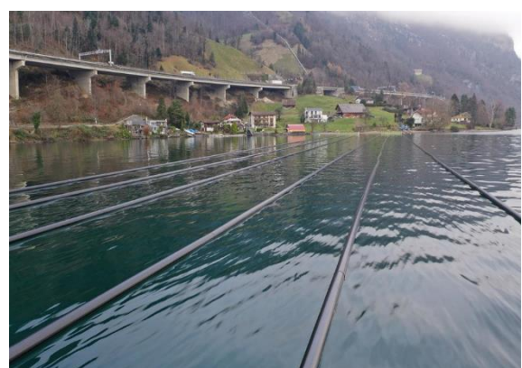
Rohrstränge auf dem Urner See schwimmend Foto: Elisa Hipp/Urner Wochenblatt
