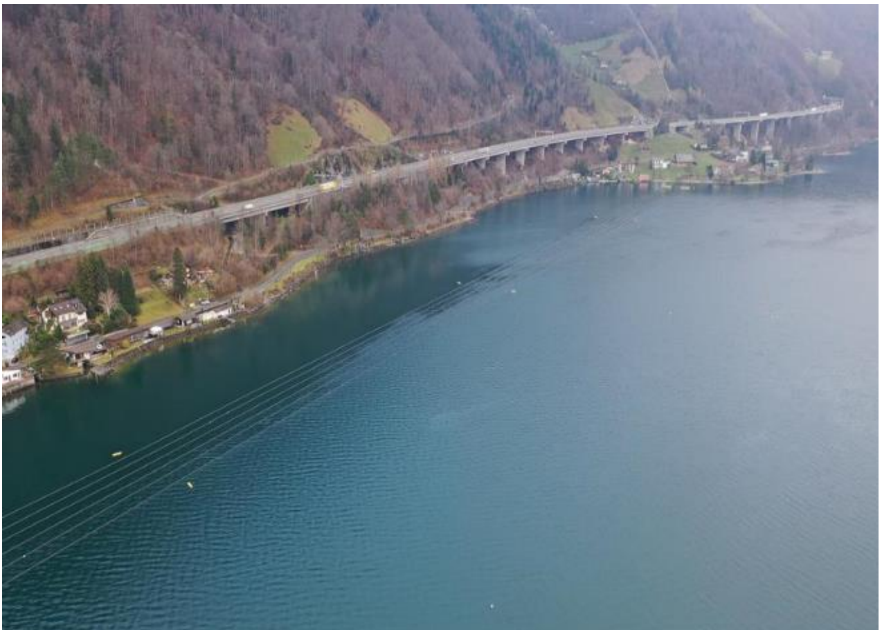
Rohrstränge/Rohrlager auf dem Urnersee
