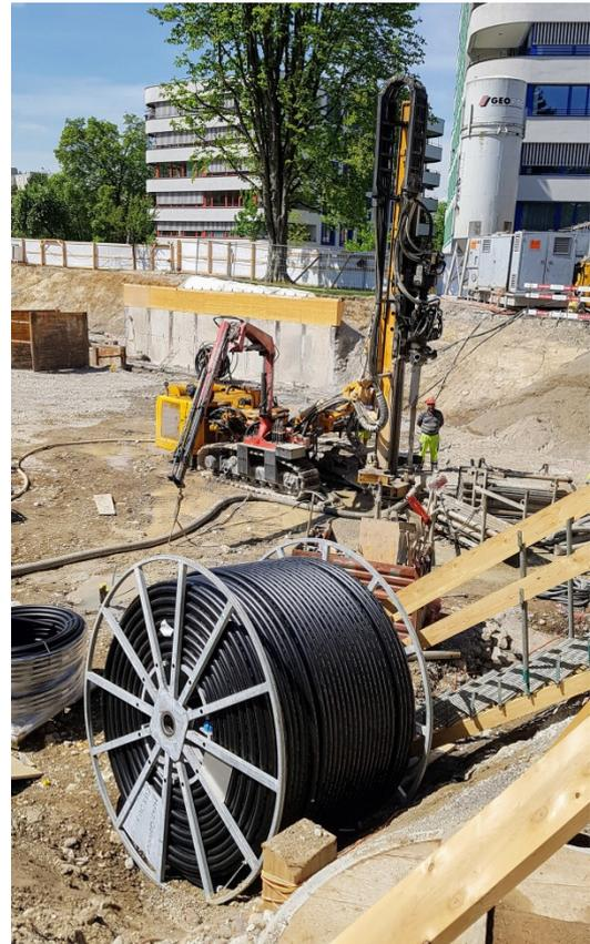
**Bild 2+3: Bohrgerät mit Erdwärmesonde GEROtherm® für den Einbau bereit**
