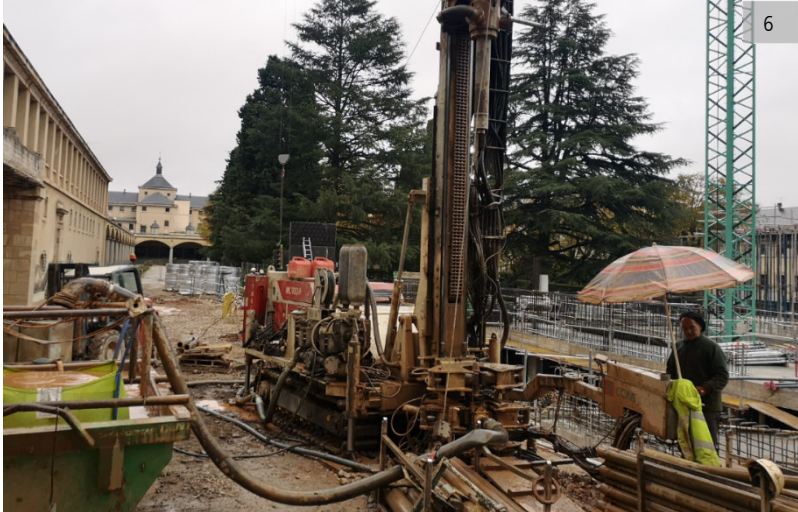
Bild 6: Bohrarbeiten mit Comacchio MC900P Quelle: HakaGerodur
