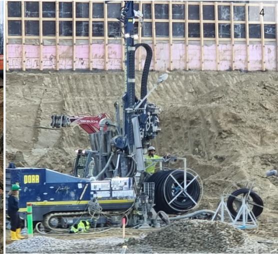
Auf dem Bohrfeld wurden 141 GEROtherm® DUPLEX Erdwärmesonden mit Längen von je 190 Meter abgeteuft. Aufgrund der komplexen Baugrubensohle mit einer Vielzahl an unterschiedlichen Aushubniveaus mussten die Erdwärmesonden in mehreren Schritten gekürzt werden. Die für die Erdwärmesonden-bohrungen spezialisierte Firma PORR Bau GmbH – Abteilung Spezialtiefbau,
