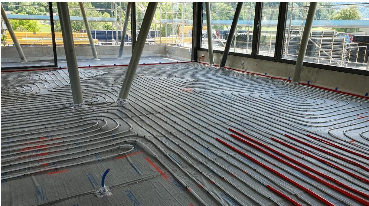
**Bild 2:** konventioneller FBH-Aufbau mit Kunststoffmetallverbundrohren, mit Tackernadeln montiert
