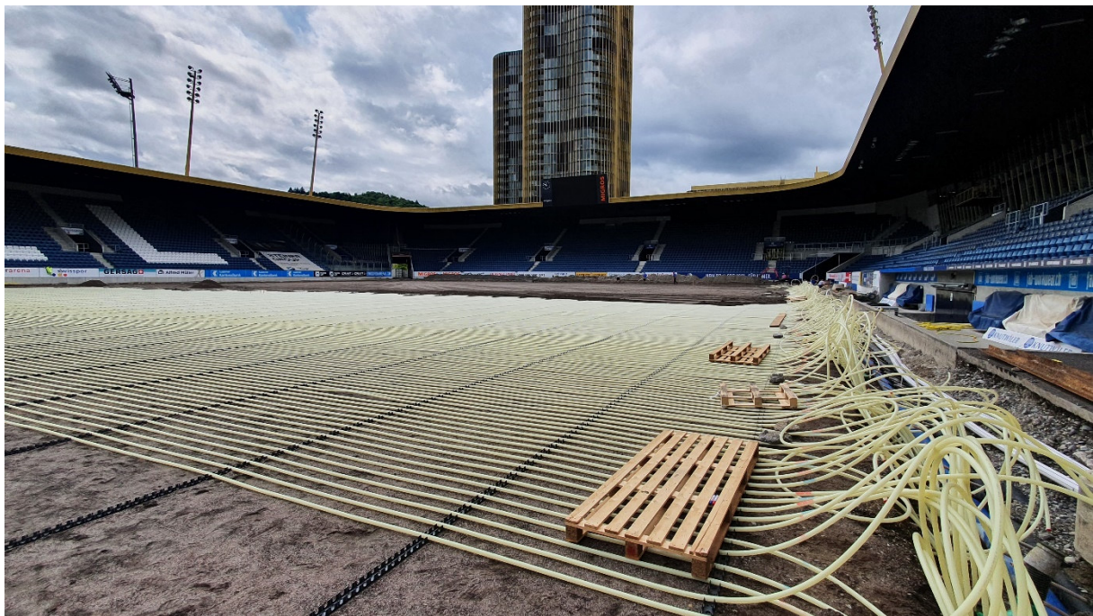
Die Verlegeschielen wurden mit Spezialnägeln von Winkler im Sand befestigt
