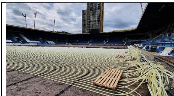
Die Verlegeschielen wurden mit Spezialnägeln im Sand befestigt
