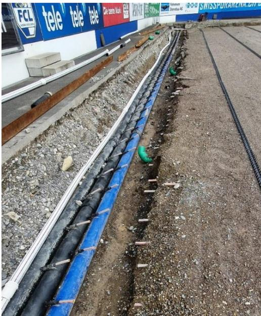
Die alten abgeschnittenen Rohre im Untergrund – darüber wurde eine neue Schicht aus Quarz-Lava Sandgemisch gelegt. Der bestehende Verteiler über die Länge des Spielfeldes blieb bestehen. Die neuen Anschlussstutzen wurden in das bestehende PE-Rohr D180 von HakaGerodur geschweisst und das Rohr mit dem Pressfitting angeschlossen.
