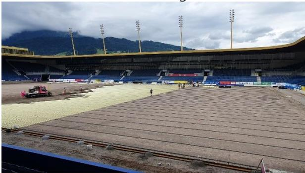
**Bild 1:** Heizrohre PE-Xc-O2 werden auf das Sandbett gelegt
