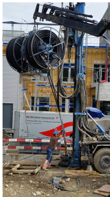
Bild 2: Einbau der Erdwärmesonde GEROtherm® VARIO mit und auf dem hydraulisch angetriebenen Haspel
