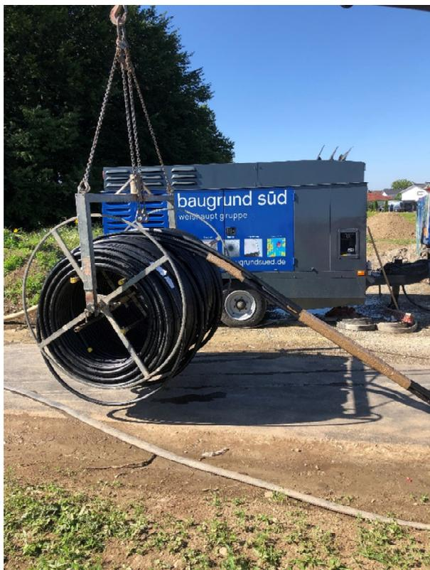
**Bild 5:** GEROtherm® DUPLEX bereit zum Abteufen
