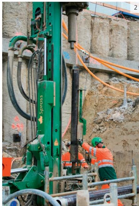
1 Bohrer mit GERotherm®-Erdwärmesonde am Kran
