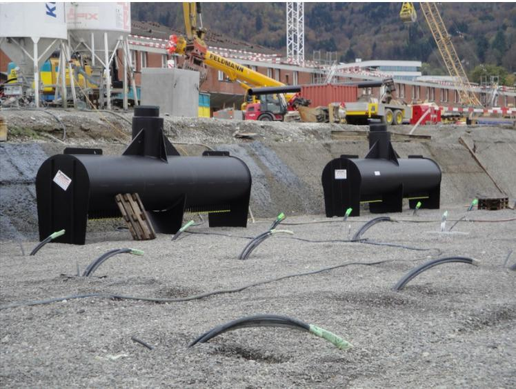
2 – Zwei der insgesamt sechs Verteilerschächte mit Sondenanschluss von unten
