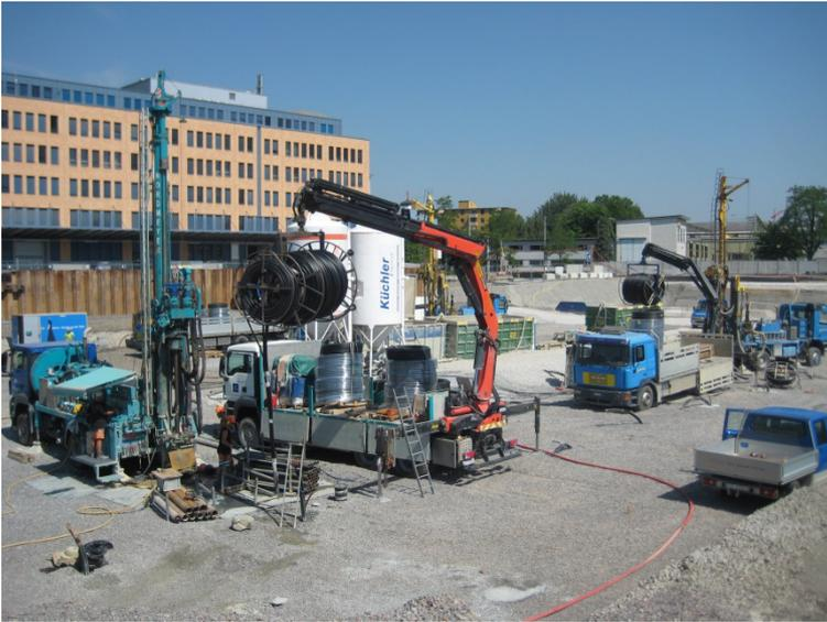
**5** – Installation der Erdwärmesonden
