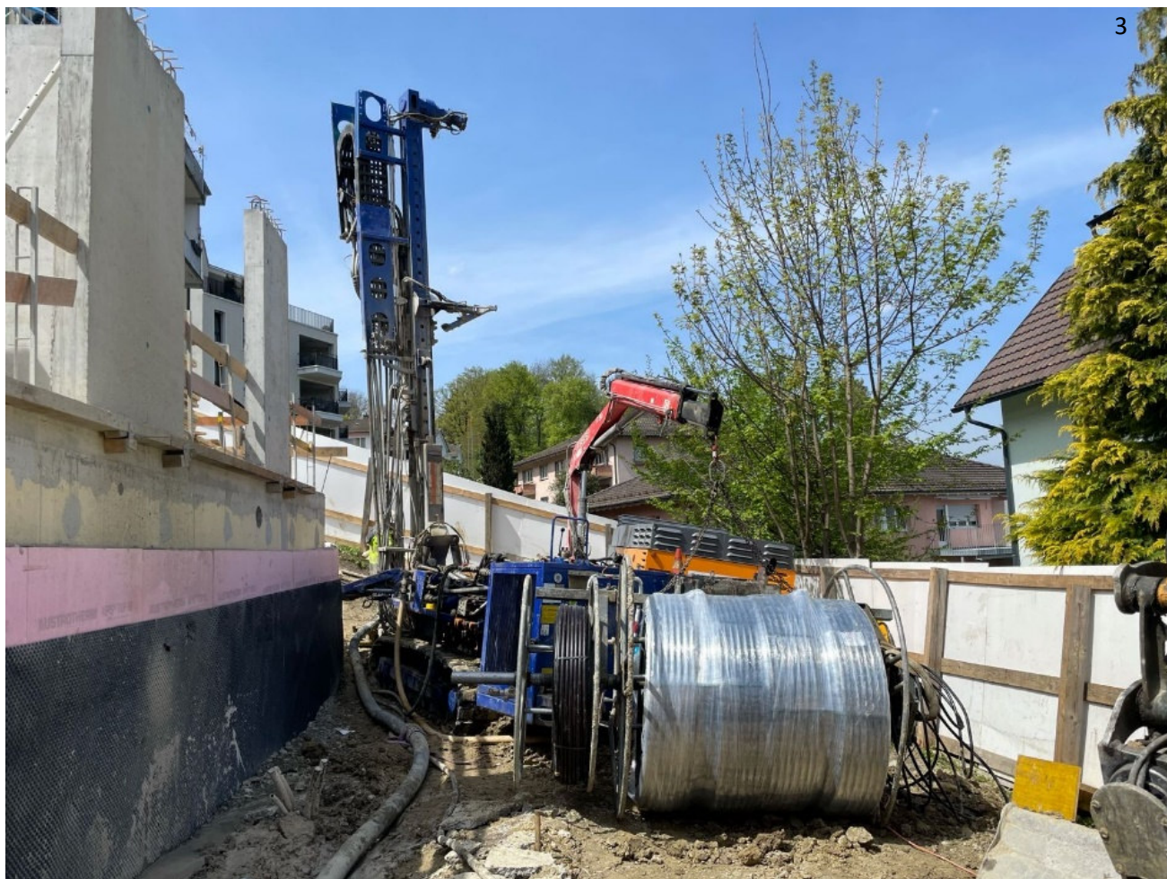
Bild 3: Erdwärmesonde bereit für den generationenübergreifenden Einsatz
