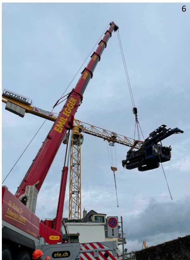
Bild 6: Das Bohrgerät wird mit dem Kran an die richtige Stelle gehoben
