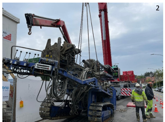
Bild 2: Vorbereitungsarbeiten auf der Baustelle
