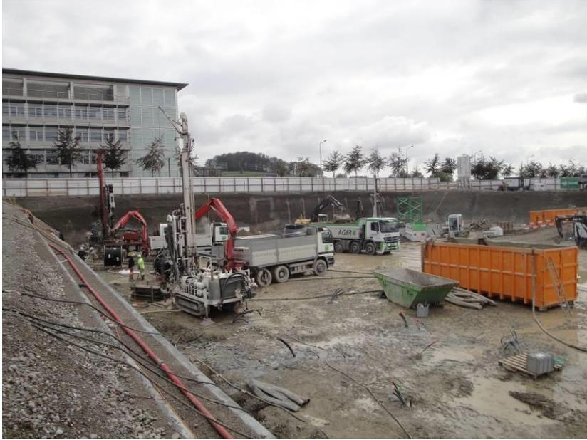
**1 – Zwei Raupen-Bohrgeräte und ein Bohrgerät auf LKW bei der Arbeit**
