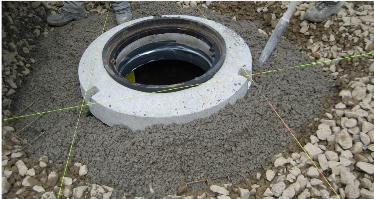
Illustration 4: Soutien de l'anneau d'appui en béton
