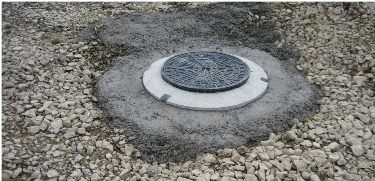
Illustration 5: Achèvement de l'anneau d'appui en béton
