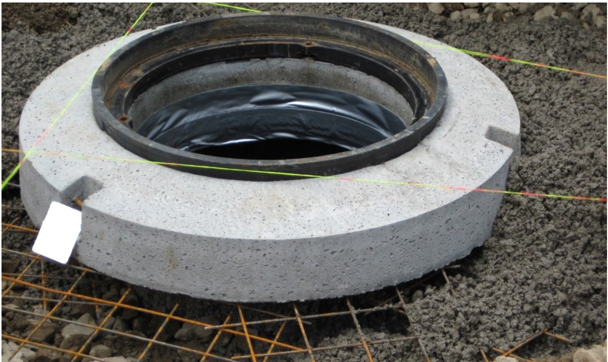
Illustration 3: Soutien de l'anneau d'appui en béton
