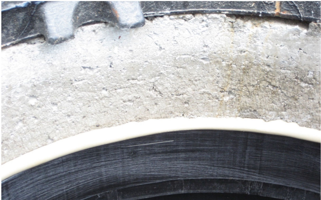
Illustration 1: Principe de couches successives avec anneau d'appui en béton
