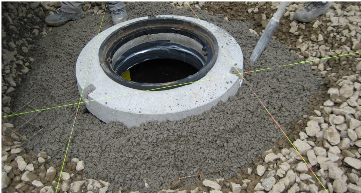
Illustration 3: Soutien de l'anneau d'appui en béton
