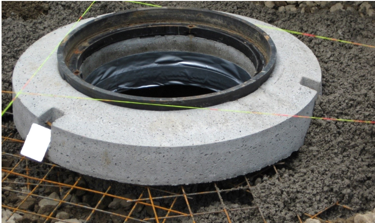
Illustration 2: Soutien de l'anneau d'appui en béton
