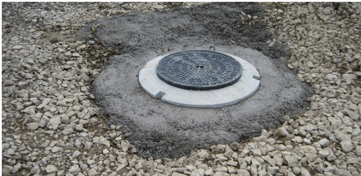
Illustration 4: Achèvement de l'anneau d'appui en béton
