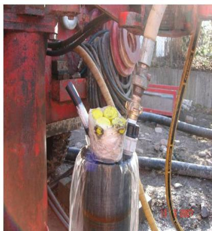
7. Remplir le PACKER avec le tuyau d'injection de ciment et le maintenir sous pression jusqu'à ce que le ciment ait pris.
