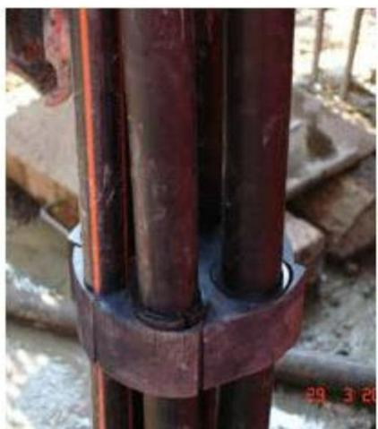
4. Placer l'élément d'étanchéité du PACKER supérieur dans la position souhaitée.
