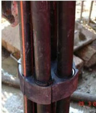
2. Placer l'élément d'étanchéité du PACKER inférieur dans la position souhaitée.
