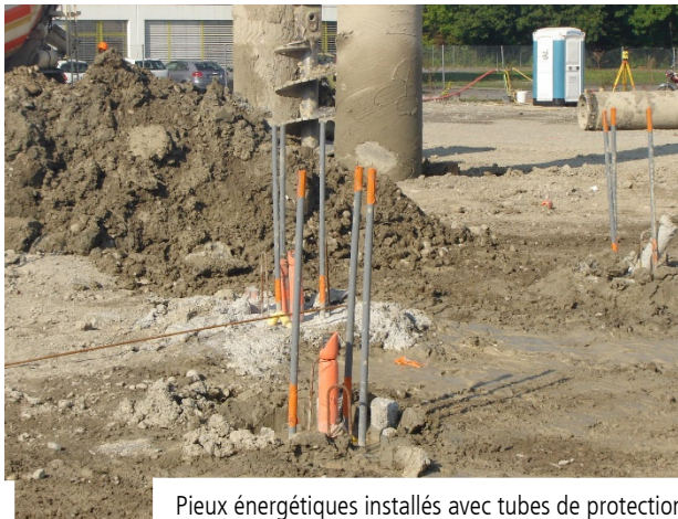
Pieu énergétique équipé de sondes en U simples
