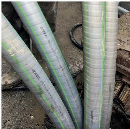
6 Flèches de sens d'écoulement et métrage des deux côtés comme pour les sondes standard
