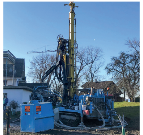
7 GEROtherm®-REX dans le forage; au fond la foreuse
