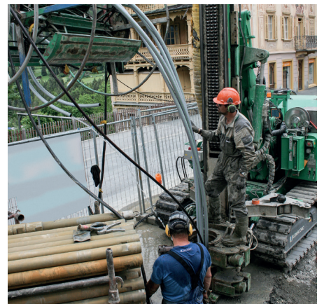
8 Les derniers mètres lors de l'enfouissement dans le puit de forage de cinq unités double U de 40mm GEROtherm®-REX à 152 m
