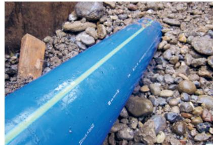
L'avantage lors du soudage des GEROfit® R est que la gaine protège quasi continuellement le tuyau. La gaine n'est interrompue que de quelques millimètres au cordon de soudure. Pour la première utilisation, nous proposons une formation sur chantier. Contactez-nous!
