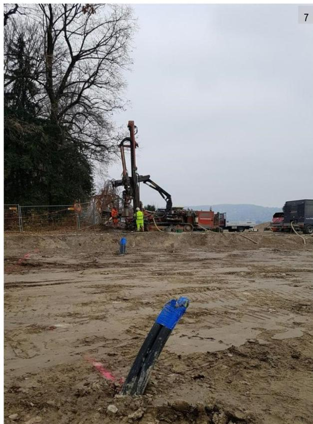
Image 7: Sondes géothermiques déjà foncées, comblées et contrôlées quant à leur pression
