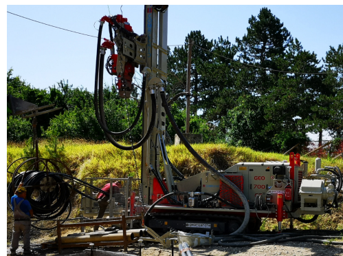
Das Bohrgerät Comacchio GEO 700 GT der Bohrfirma Georicerche srl
