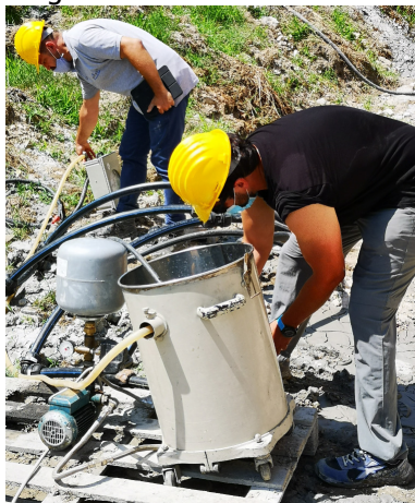
Vorbereitung zum TRT
