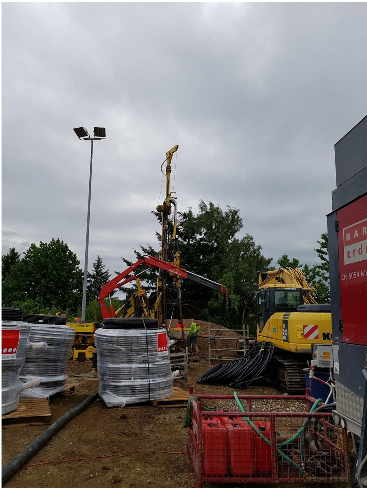
Photo: Outillage de forage avec sondes GEROtherm® FLUX
