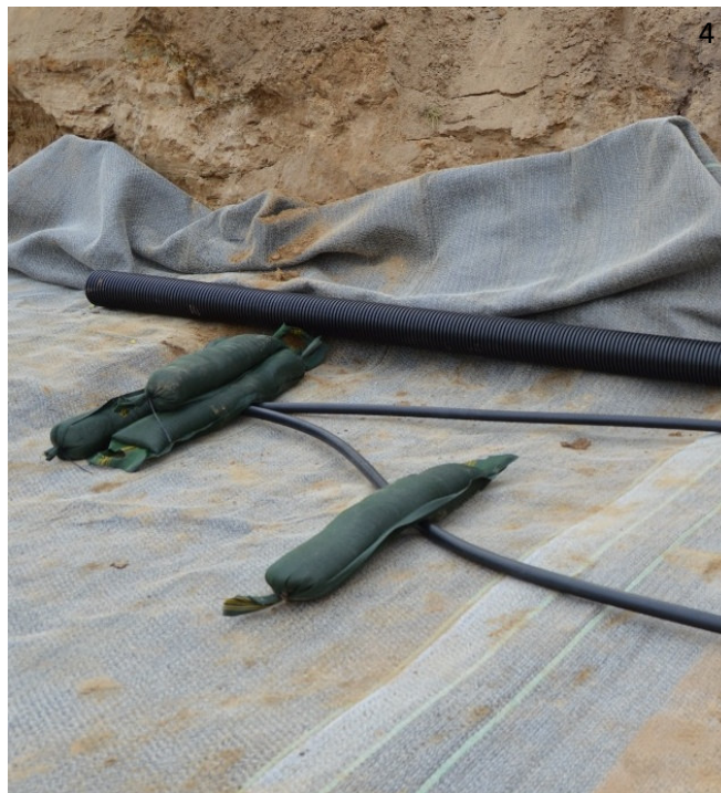
Illustration 4: Sonde GEROtherm® en tant que collecteur horizontal
