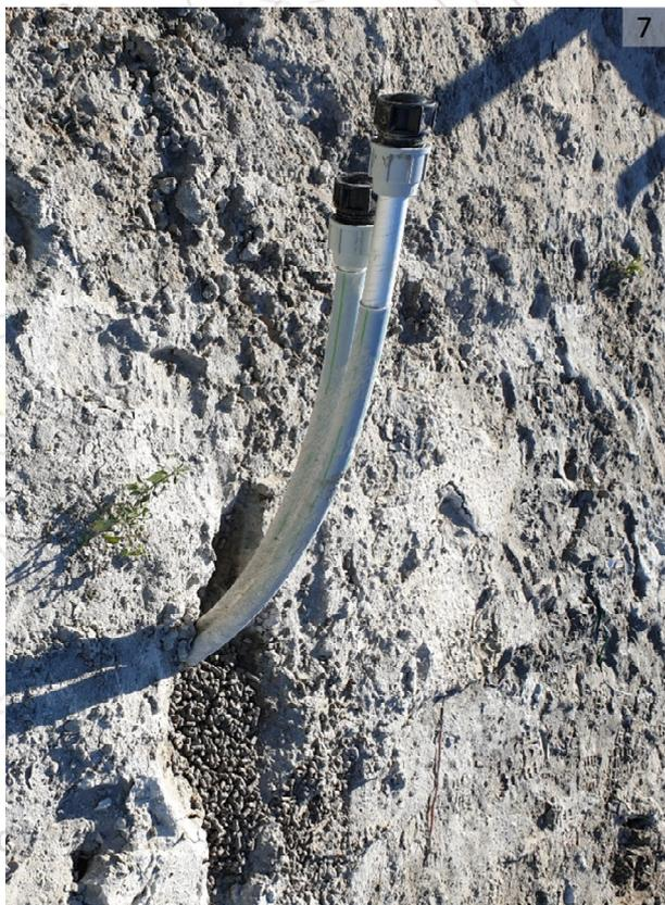
**Image 7:** Sonde géothermique GEROtherm® REX déjà foncée
